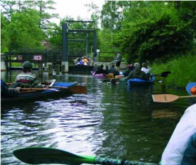
Abb. 13: Trotz Umtragemöglichkeit warten Kanuten an der Hubtorschleuse Waldschlösschen
